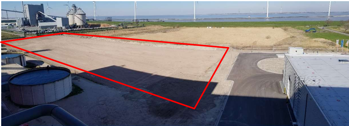
Abbildung 1 Der geplante Standort für die vierte Linie von EEW Delfzijl an der Nordseite der heutigen Anlage. Das Foto wurde vom Dach des Gebäudes aus genommen. (Quelle: eigenes Foto)
