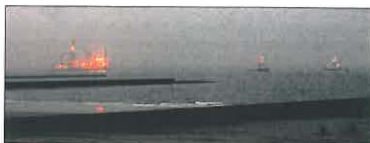
Abb. 17: Kabelleger und Wachschiße bei den Arbeiten zu BorWin3 in der Dämmerung.
